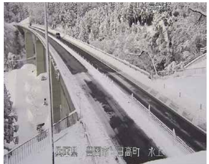
山本高架橋の融雪状況
