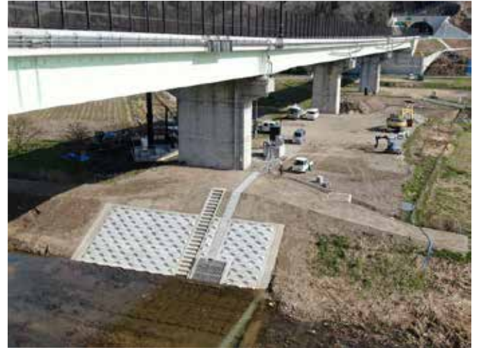
八代川にある取水設備
