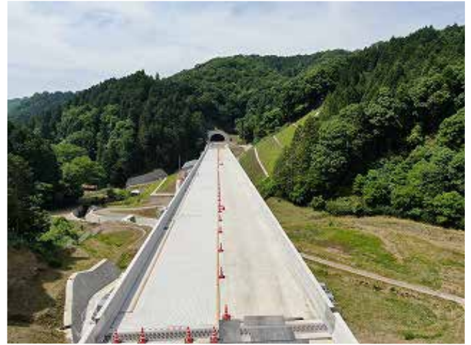
【祢布川橋】上空10m地点
