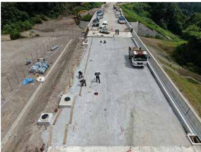
【水上1号橋豊岡側】据付前：R02.08.03 撮影
