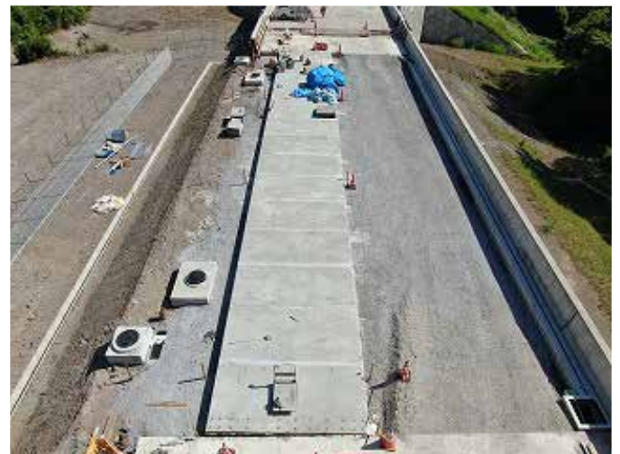
【水上1号橋豊岡側】据付後：R02.08.17 撮影
