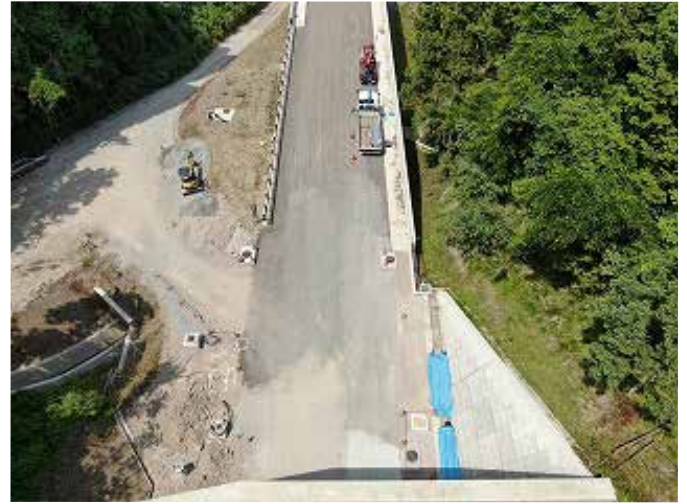
【祢布トンネル豊岡側】据付前：R02.06.05 撮影
