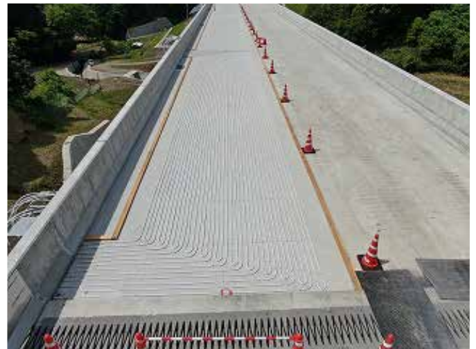
【祢布川橋】上空5m地点
