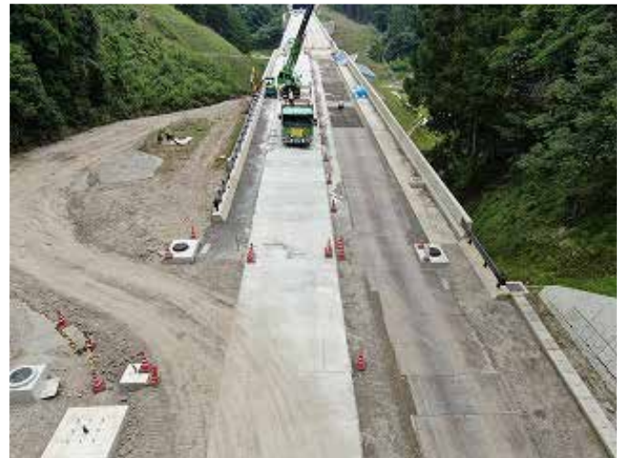
【祢布トンネル豊岡側】据付後：R02.08.03 撮影
