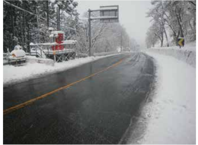
笠波峠頂上付近の散水融雪状況
