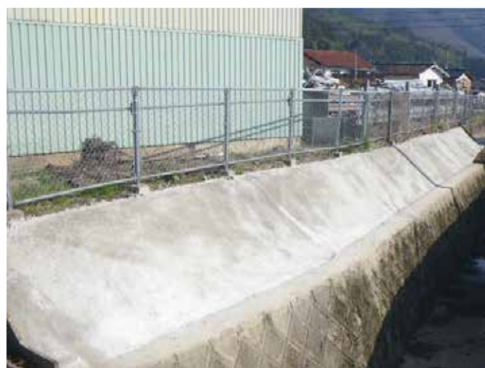
コンクリートで補修
