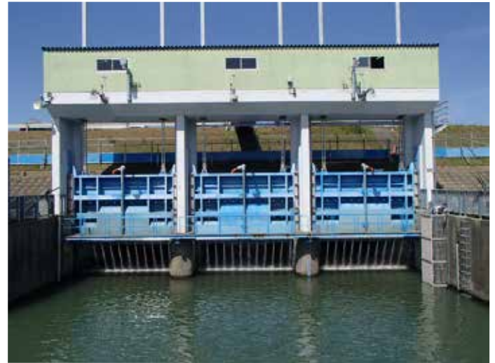
高川樋門全景
