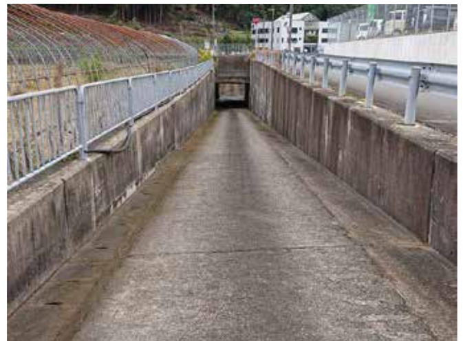
清掃後のアプローチ部。奥に社屋が見えます。
