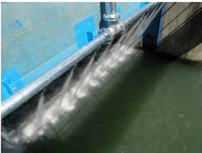
水を噴射し河床の土砂を除去します
