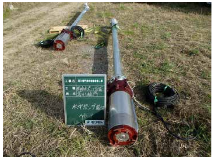
2台のポンプを用いて河川水を組み上げます
