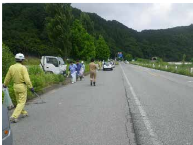
国道312号線 八鹿町宿南地内
