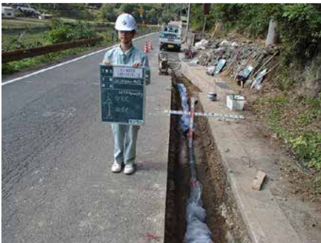
水道管布設現場での計測補助
