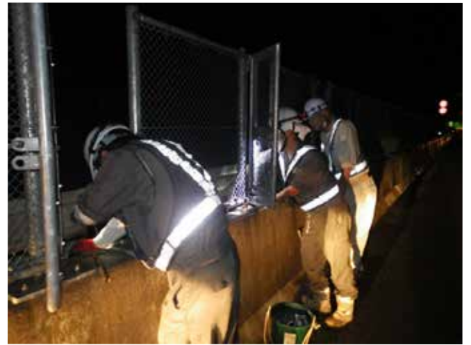
高架道路外側の設備を点検します
