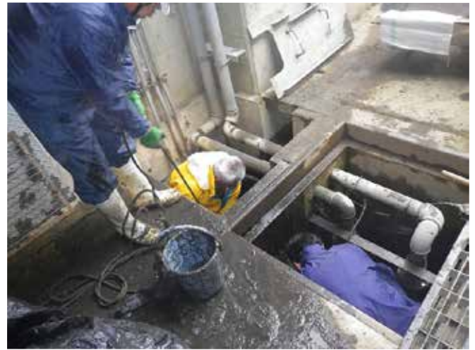
排水ピット内の汚泥を除去しました
