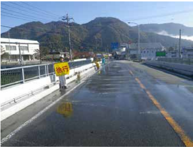
国道312号和田山町の与布土川橋
