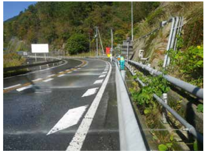
国道9号関宮ループ橋の頂上付近
