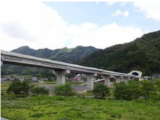
写真は 小佐川橋
