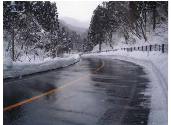
のべ積雪高さ2mを越えているとのこと。
