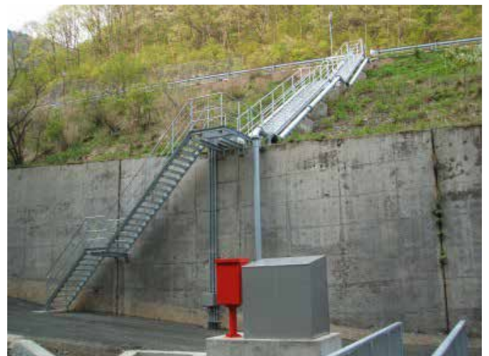
新設管理用階段
