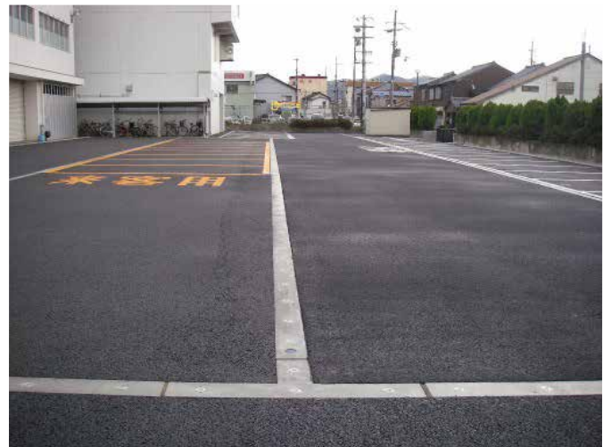
排水性舗装駐車場全景
