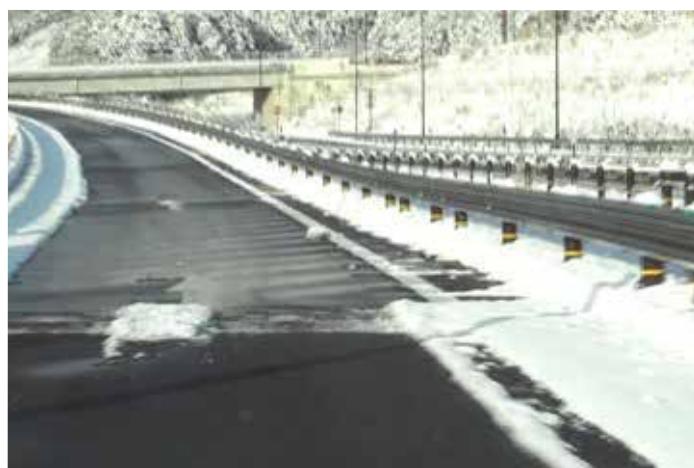
上り線流出路の融雪状況
