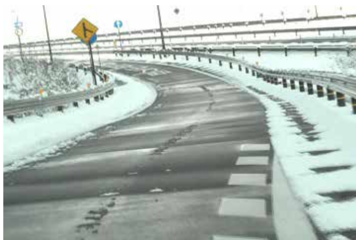
上り線流入路の融雪状況
