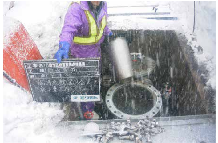
上写真は緊急出動における設備整備状況。
